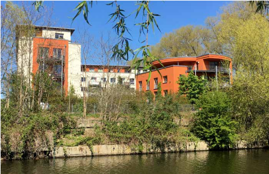
Wohnprojekt Saarlandstraße: Rückansicht mit Osterbekkanal
