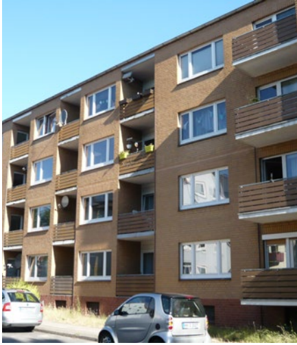
Jugendstraße: Deftige Mieterhöhungen nach Modernisierung angekündigt
