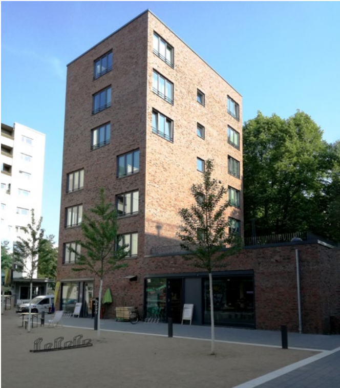
Auf dem Gelände der ehemaligen Pestalozzi Schule in St. Pauli ist das kleingemossenschaftliche »Wohnkollektiv Kleine Freiheit« der Wohnungsbaugenossenschaft Schanze eG. mit 28 Wohnungen und einem Bio Laden und Cafe Betrieb im Erdgeschoss entstanden. Fertigstellung 2017.
