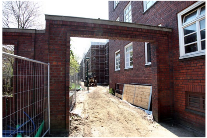
Denkmalgeschützte Fassade: Genossenschaftswohnungen in Hamburg-Bahrenfeld
